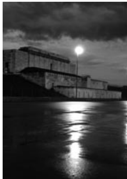
Natsien rakennuttama Zeppelinwiese Nürnbergissä.
